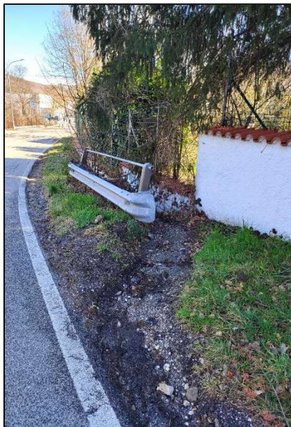
Dettaglio deflusso insicriminato delle acque bianche lato destro Via San Salvatore, direzione di marcia Ovest Est
