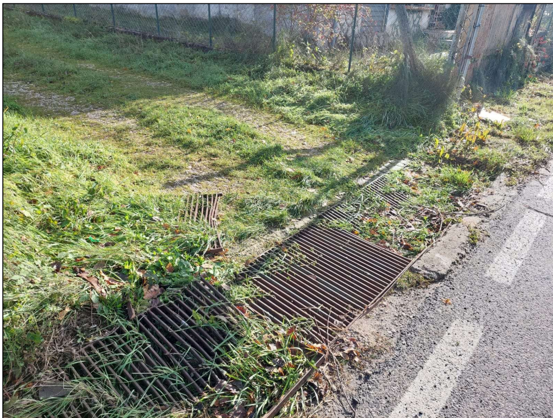
Foto esemplificativa dello stato di fatto del pregresso sistema di regimentazione idraulica della via L'Aquila
