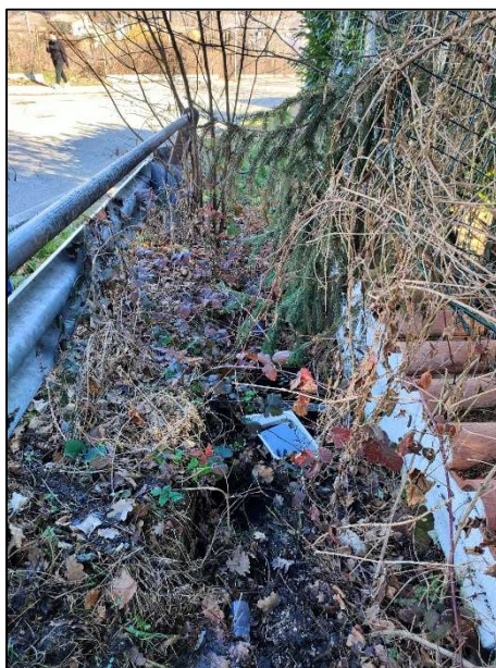
Dettaglio deflusso insicriminato delle acque bianche lato destro Via San Salvatore, direzione di marcia Ovest Est
